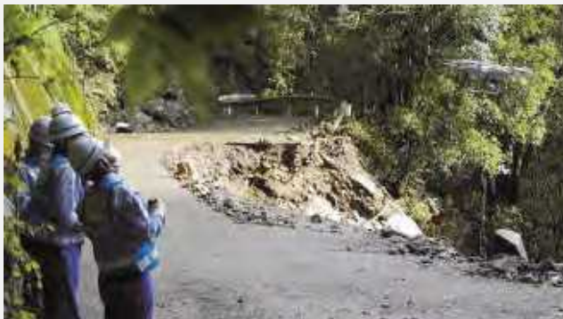
▲ 危険箇所調査のため、ドローンを活用
