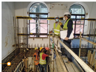
現在進捗中の大使館事務所増改築工事現場の様子
