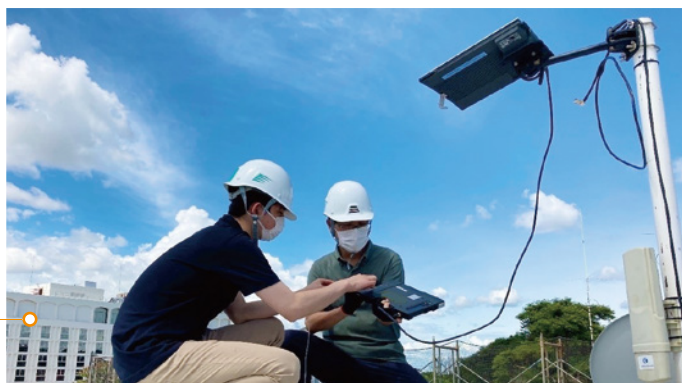
在ザンビア日本国大使館でインマルサット衛星通信機器設置
